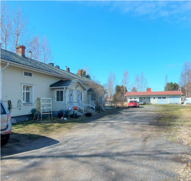
Kuva 25. Rentukan asunnot (kuva: Hailuodon kunta).
