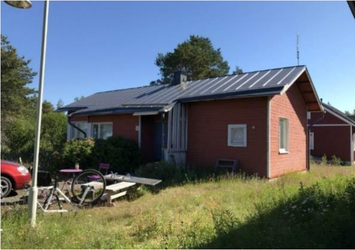
Kuva 14. Talonmiehen asuinrakennus (kuva: Sweco).
